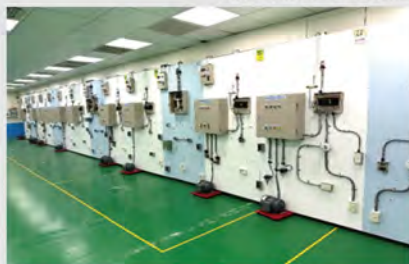
勞動部「室內配線乙、丙級」技術士考場
