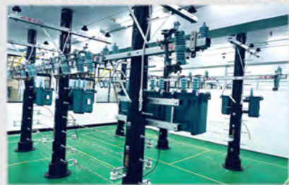
勞動部「室內配線乙、丙級」技術士考場
